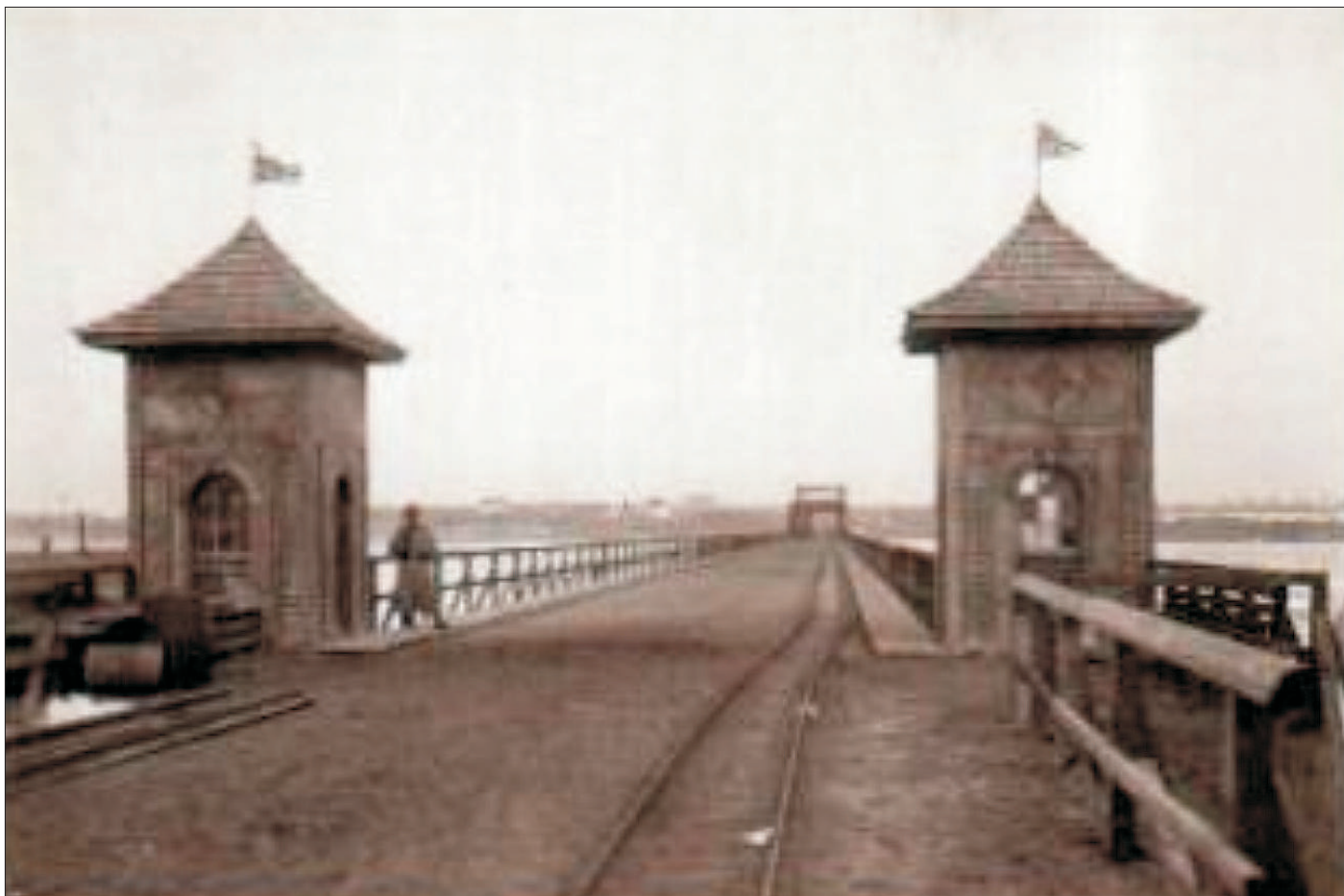
Most w Wyszogrodzie, widoczne tory Feldbahn (kolejki polowej), ok. 1917.
